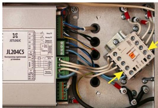
**Внимание!** Подключение к контактору допускается только при обесточенной (отключенной с электрощита) вентустановке. При включенной вентустановке на остальных клеммах контактора, кроме указанных стрелками, присутствует высокое напряжение.
